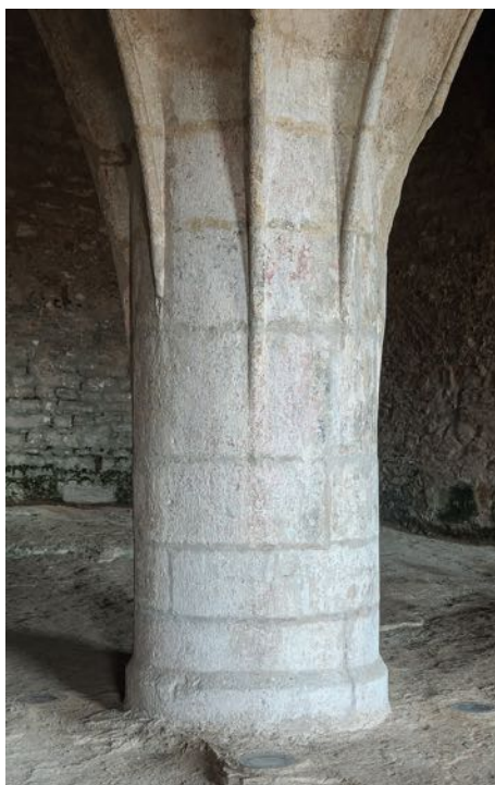
Kutná Hora. Kaple Božího těla. Sloup s náběhy kleneb.
